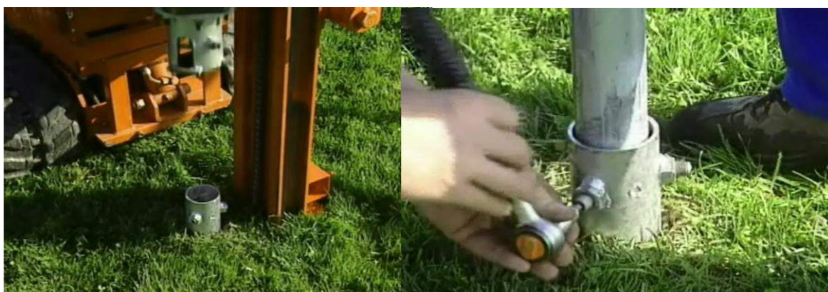
Слика 17. Вкопан клин во земја и поставување на носечката конструкција
